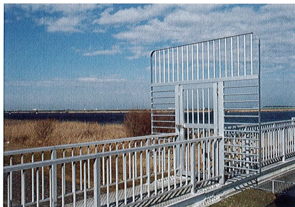
★アルミ製侵入防止柵・門扉
