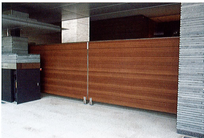
★ステンレス門扉枠ガラス張り電動門扉
